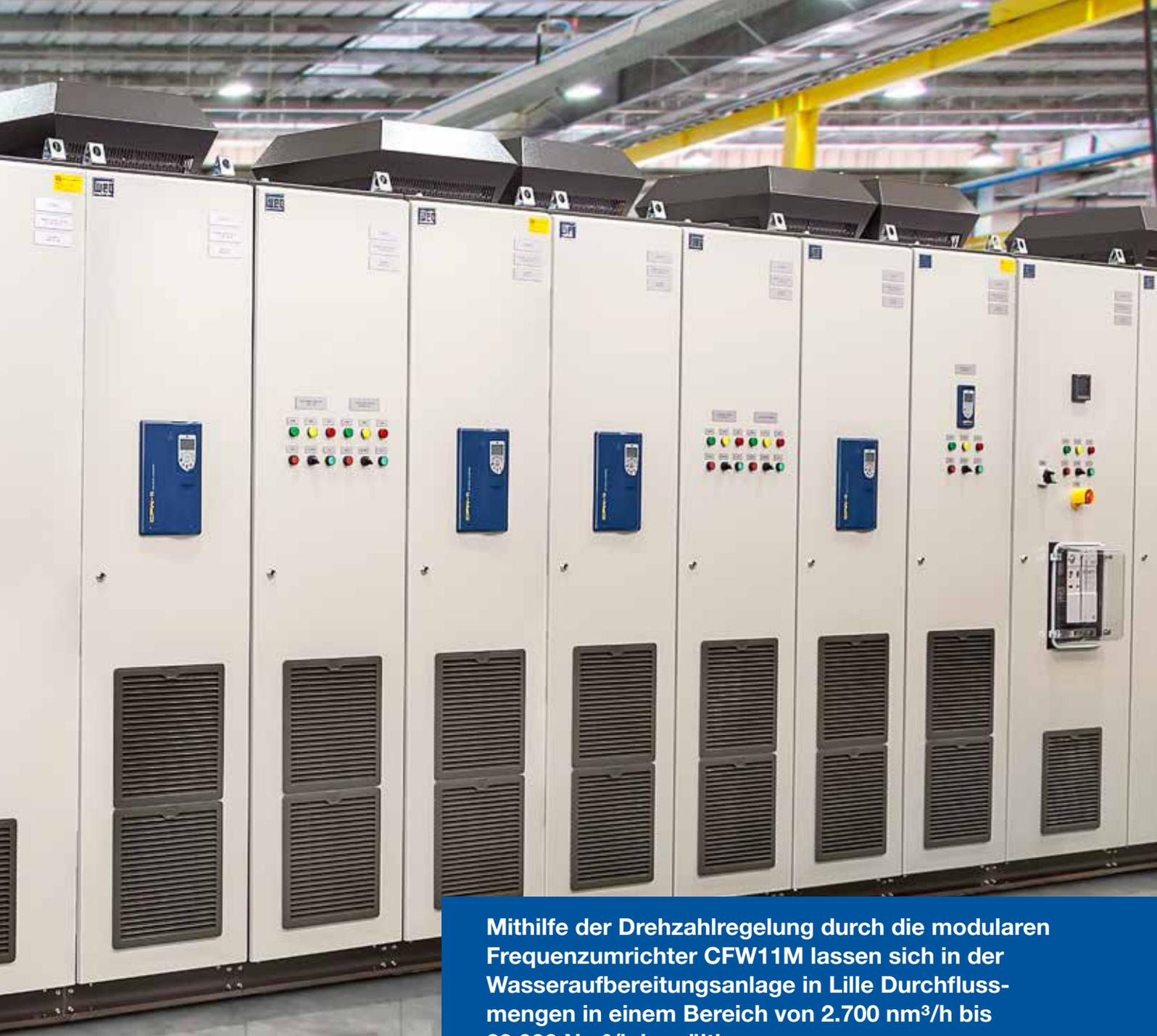
**Mithilfe der Drehzahlregelung durch die modularen Frequenzumrichter CFW11M lassen sich in der Wasseraufbereitungsanlage in Lille Durchflussmengen in einem Bereich von 2.700 nm<sup>3</sup>/h bis 23.000 Nm<sup>3</sup>/h bewältigen.**
